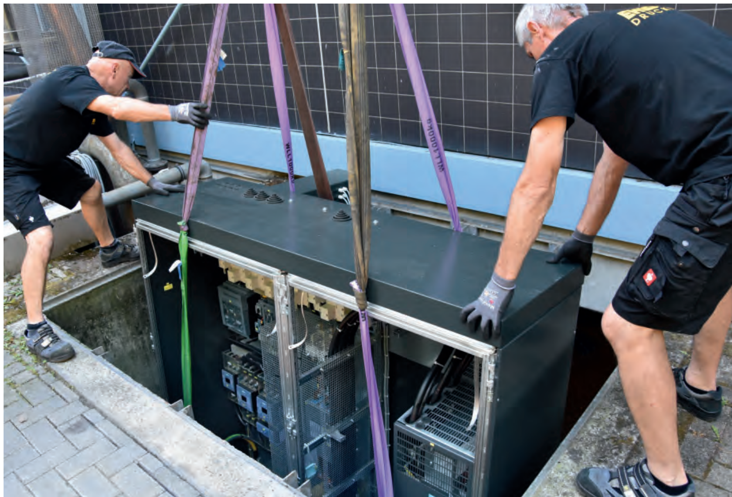
Корпус установки проходит через шахту подвального окна
