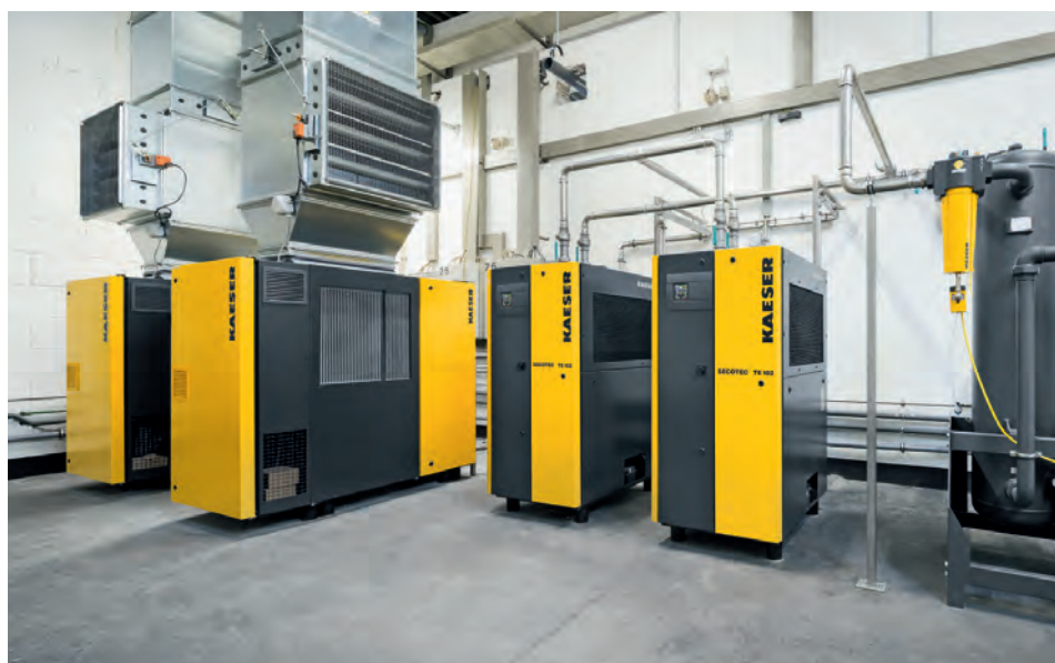
Сжатый воздух отвечает самым строгим требованиям класса качества 1.4.1 согласно DIN ISO 8573-1
